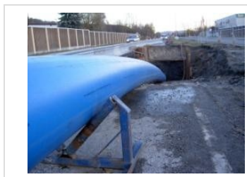
Figur 9.8 - PE-røret beskyttes mot ytre skader.
