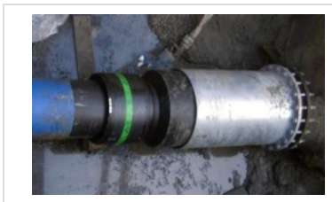
Figur 9.14 - Flensetilknytning til kum med varmforsinket styrerør.
